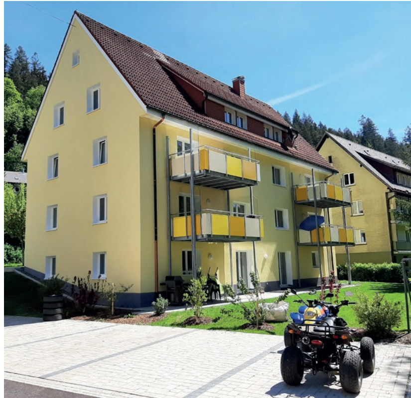
Bernau-Menzenschwander Str. 49 nach der Sanierung.
