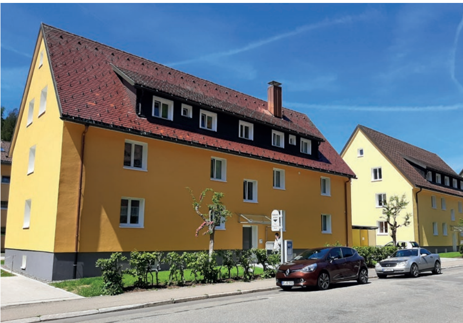
Bernau-Menzenschwander Str. 29/31 nach der Sanierung.
