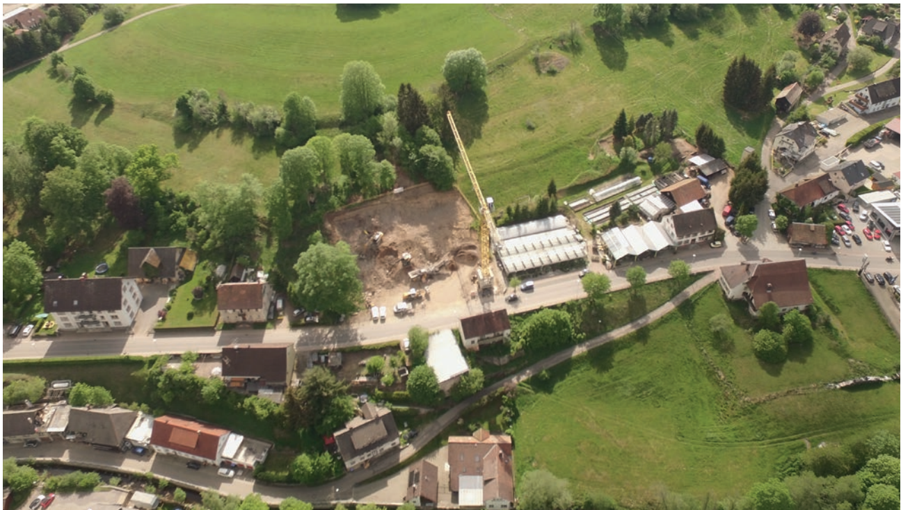
Lenzkirch – Aushub Baugrube im Frühjahr 2020.
