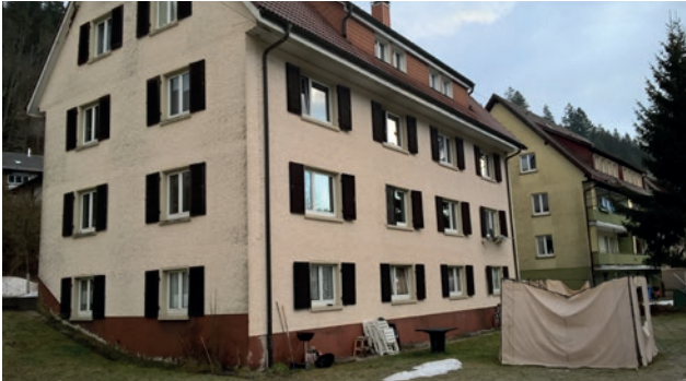
Bernau-Menzenschwander Str. 49 vor der Sanierung.
