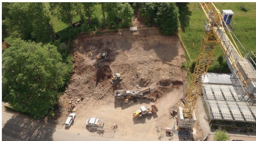
Lenzkirch - Aushub Baugrube im Frühjahr 2020.
