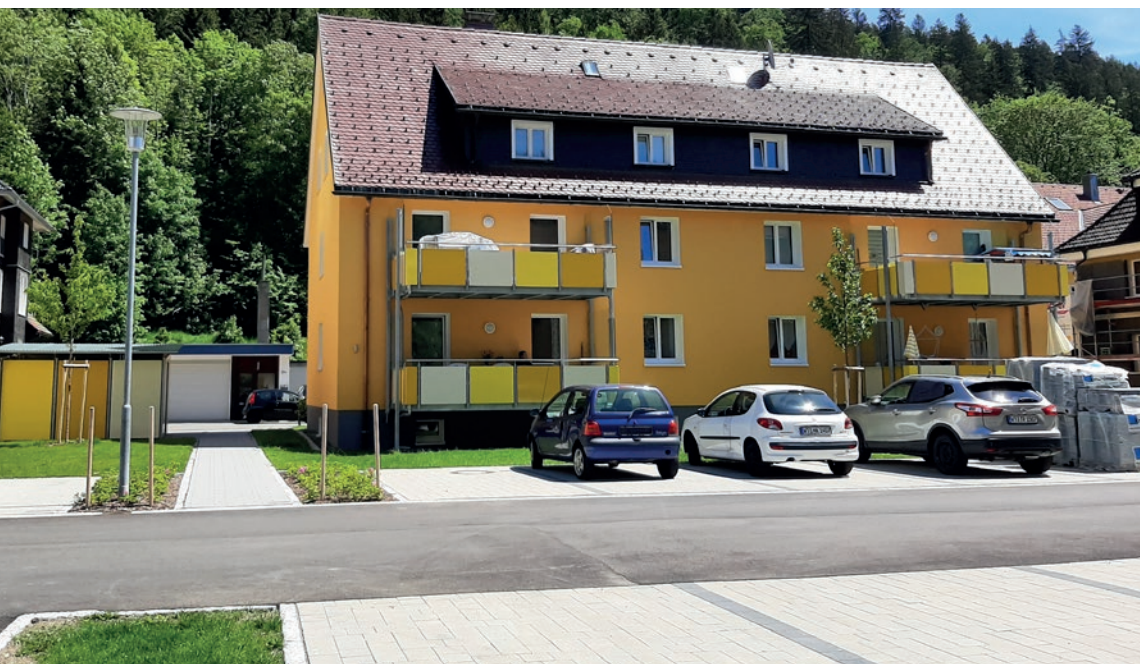
Bernau-Menzenschwander-Straße 29 in St. Blasien nach der Sanierung und mit den neuen Stellplätzen.
